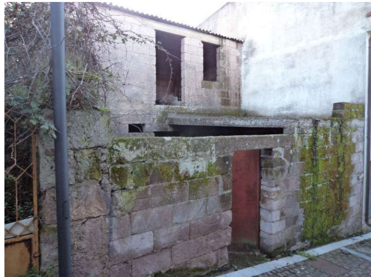
FOTO SU VIA FORRAGHE
