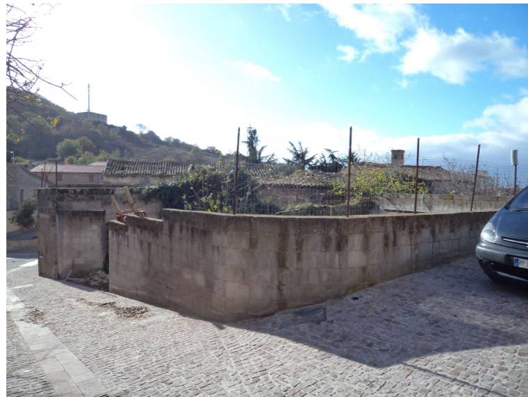
FOTO SU VIA DOTT. MURGIA
