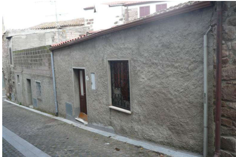
FOTO SU VIA FORRAGHE
