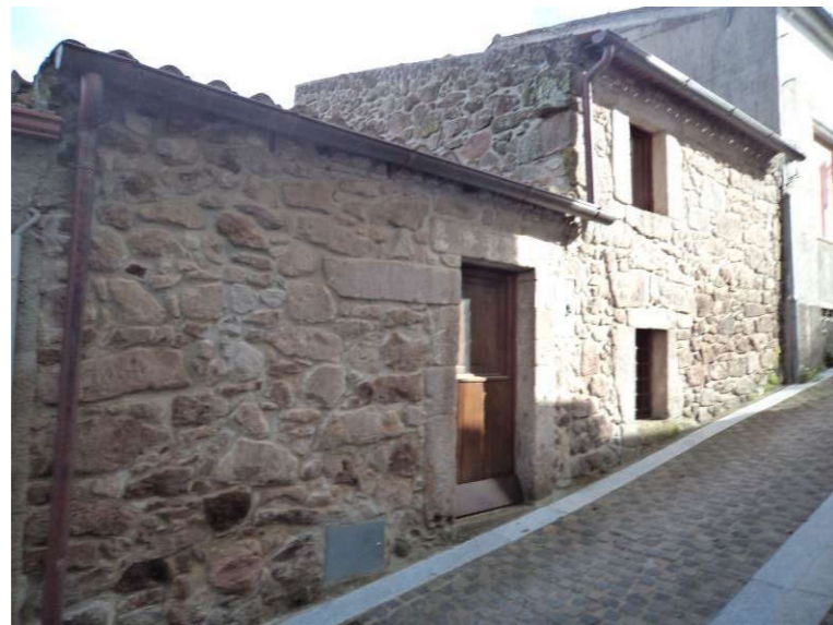
FOTO SU VIA FORRAGHE
