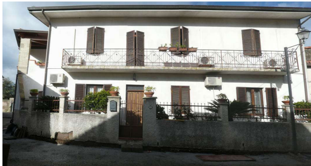
FOTO SU VIA DEI GIUDICATI
