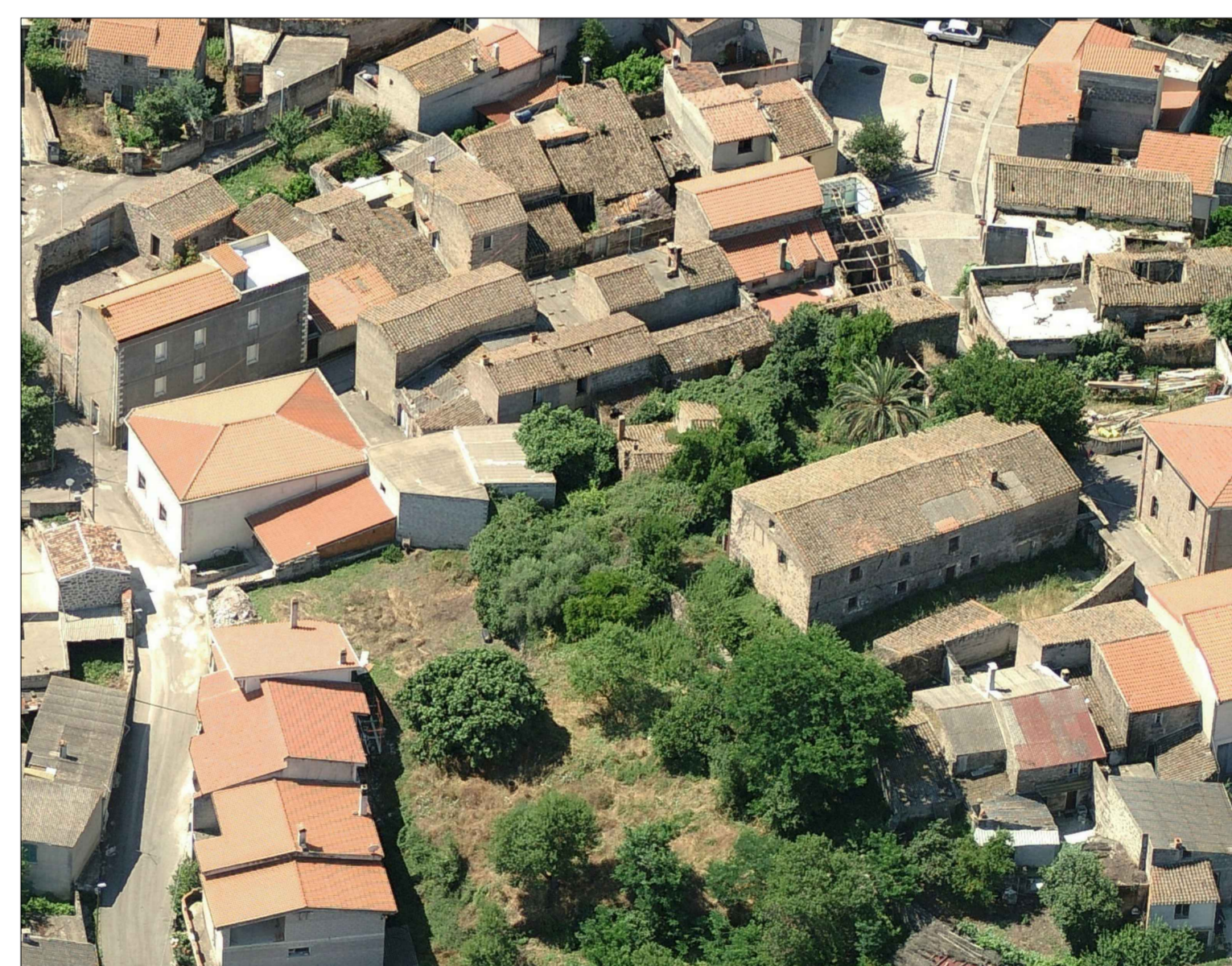
VISTA DA SUD Isolato 31
