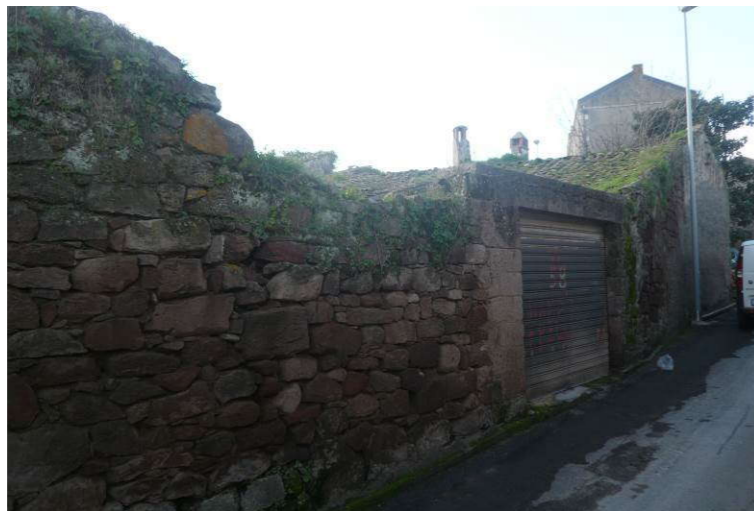
FOTO SU VIA SATTA E SU VIA DEI GIUDICATI
