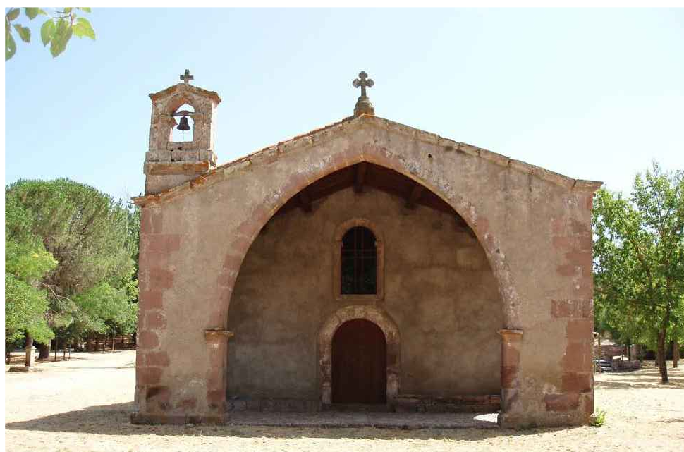
Foto prospetto Ovest
